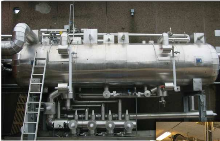
oben: NH 3 -Abscheider des Betreibers im Außengelände
