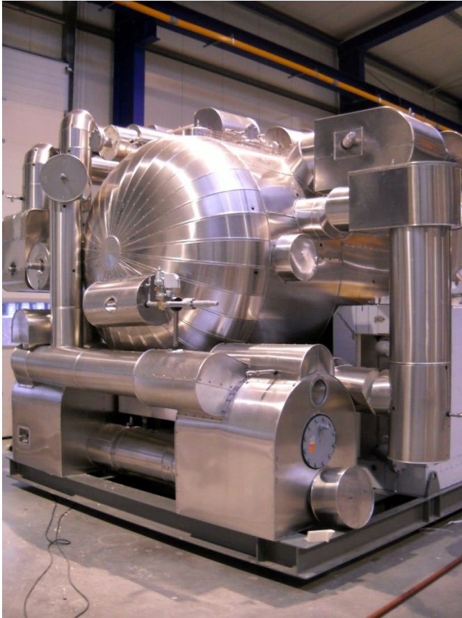
Baugruppe zur Kühlung von Toluol auf -72,5^{\circ}\text{C} während und nach Abschluss der Isolierarbeiten
