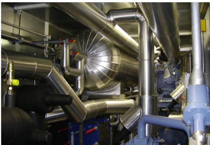
Spezialcontainerkälteanlage zur Erdgefrierung
